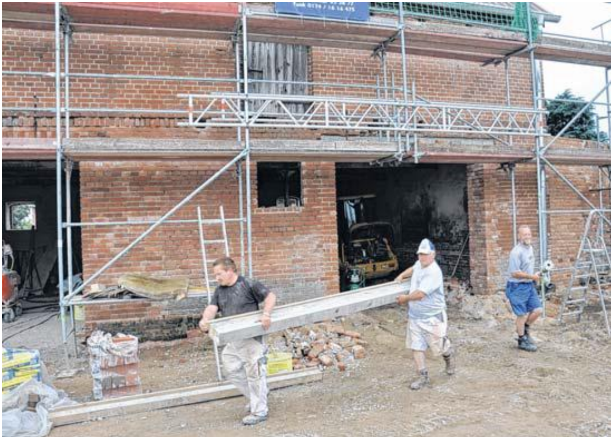
Die Maurer schufen für vier große Tore Öffnungen in der Wand
