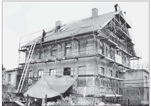
Trotz des regnerischen Wetters dieser Tage erledigen die Handwerker letzte Arbeiten auf dem Dach und an der Fassade. Fotos (2): Anke Schleusner-Reinfeldt
