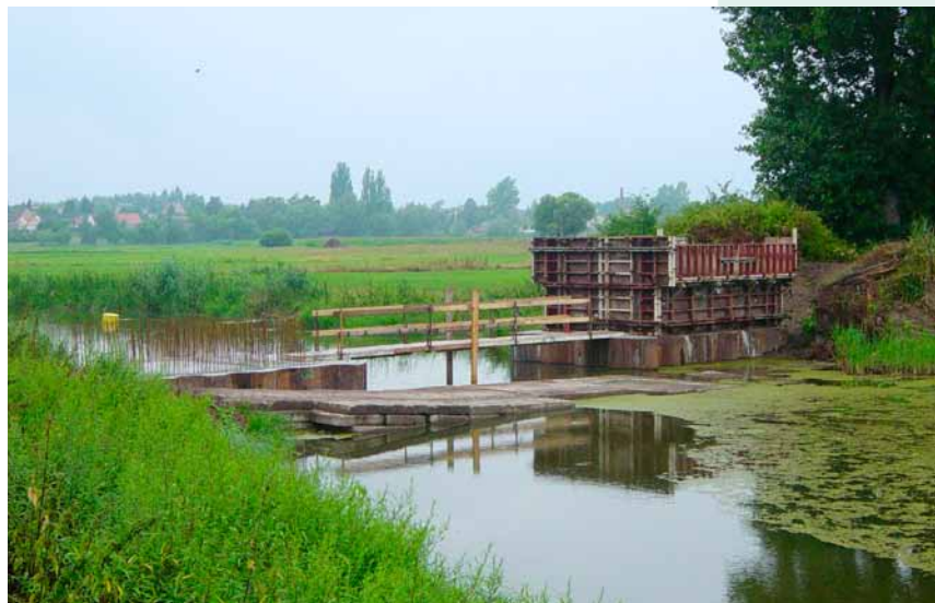
Die Weiße Brücke während der Bauphase.
