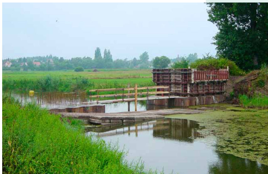
Die Weiße Brücke während der Bauphase.
