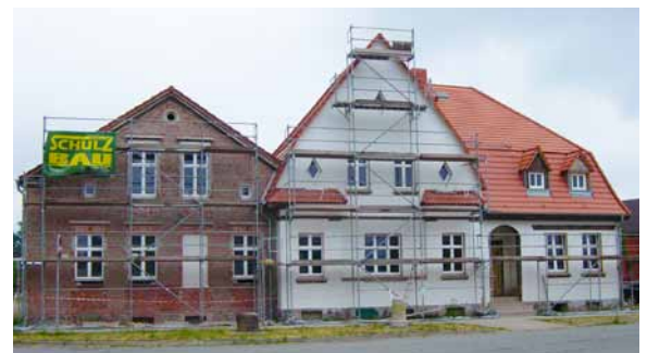
Das Bürgerzentrum in Fischbeck während der Baumaßnahme.
