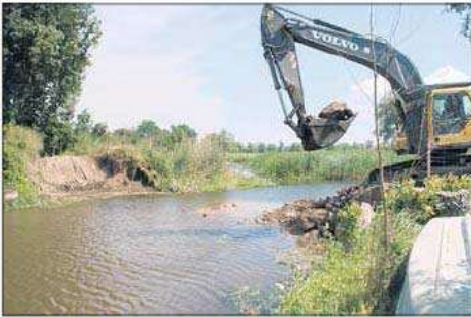
Der Bagger fasst die letzten Überreste der Brücke.
