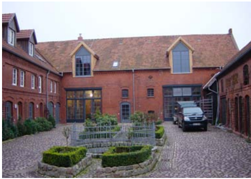
Havelhöfe in Garz 2009 Sanierung
