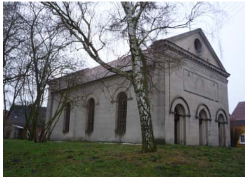
Kirche in Kuhlhausen 2011 Sanierung der Fenster
