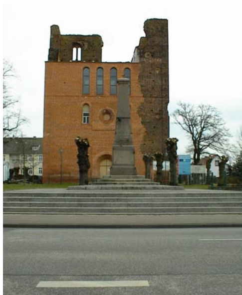
Kirche in Sandau 2005–2013 Wiederaufbau Kirchturm
